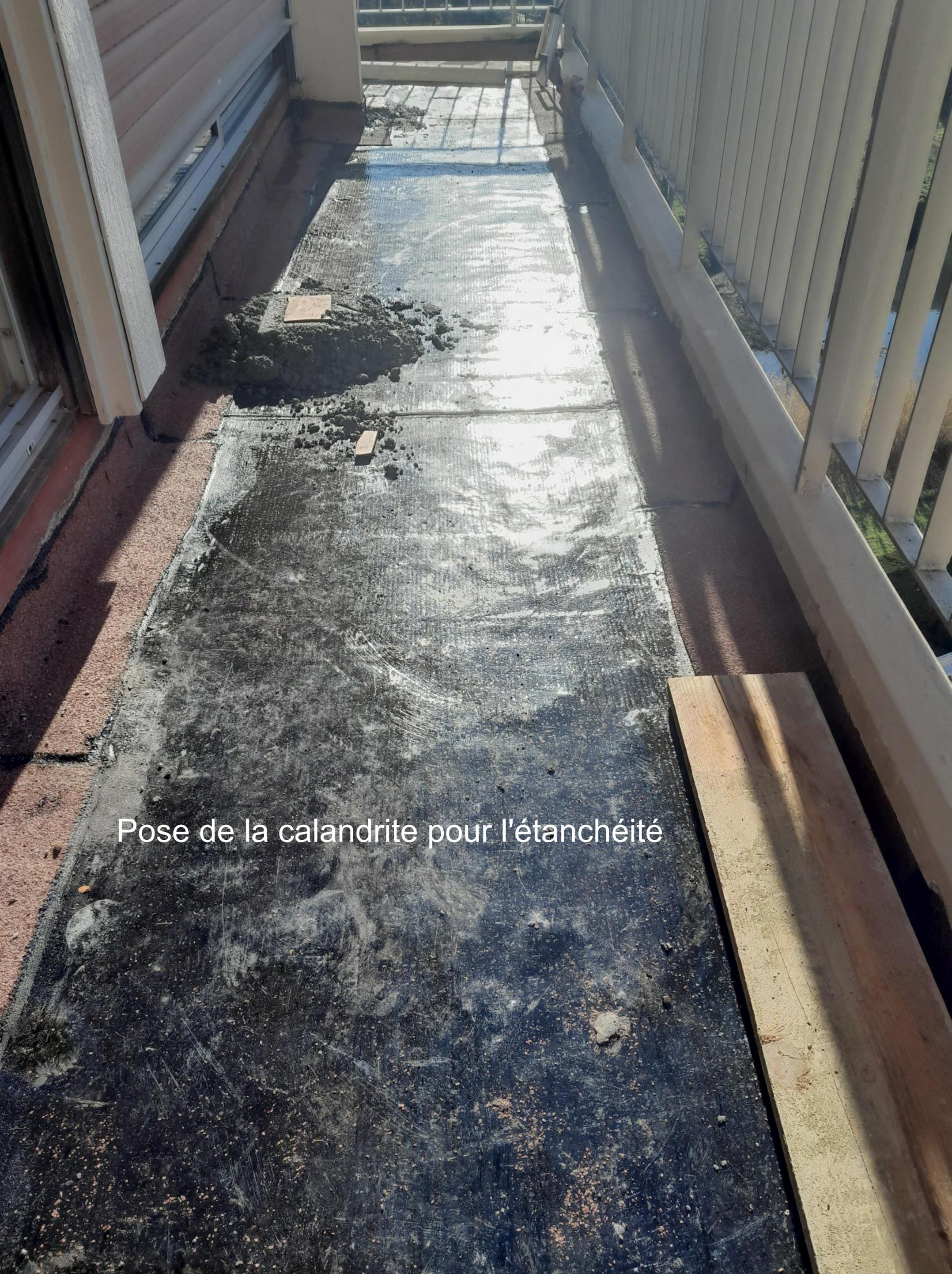
Pose de la calandrite pour l'étanchéité
