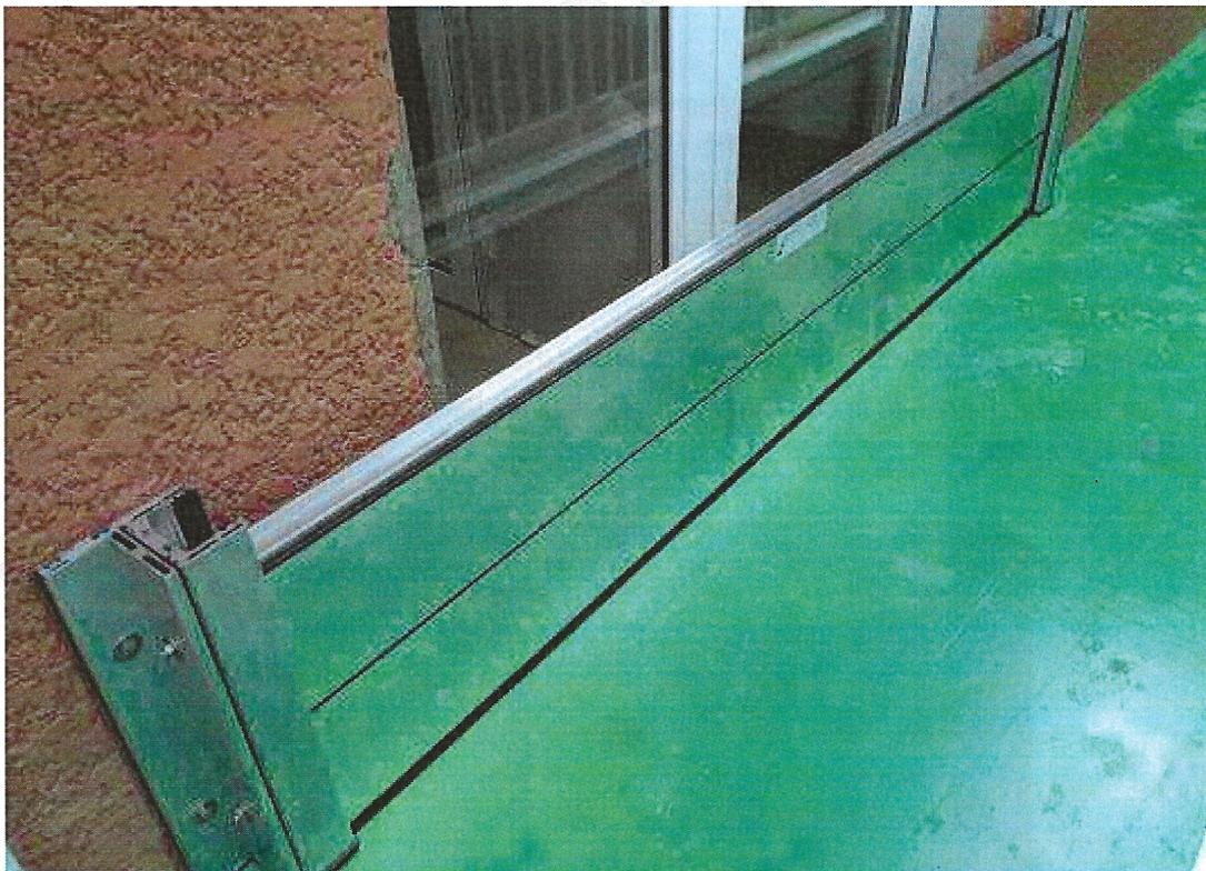
Figure 13 : exemple de barrière manuelle devant porte et fenêtres (source MSEI)
