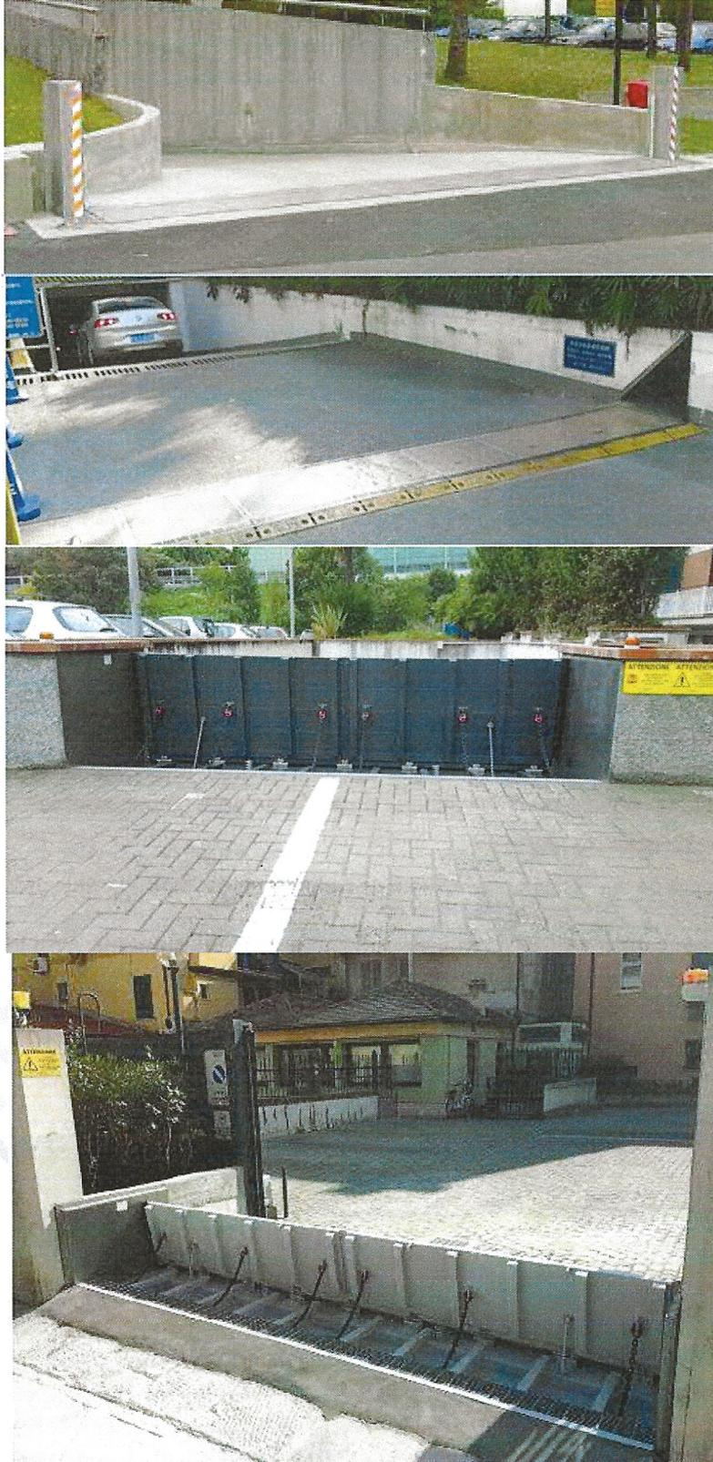
Figure 10 : Barrière passive encastrée/surélevée abaissée hors crue et barrière levée en crue
